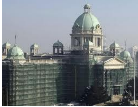
Слика 5. Реконструкција фасаде
