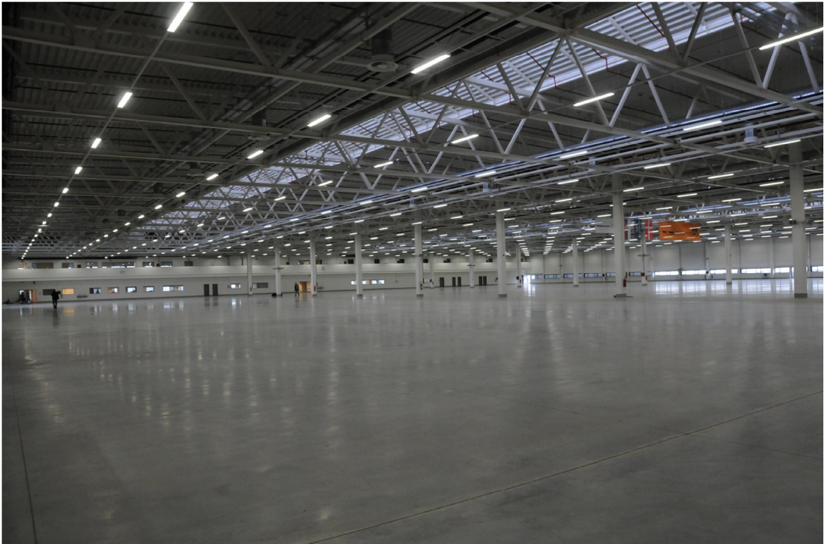
Proizvodna hala osvetljena Philips TTX400 šinskim sistemom
