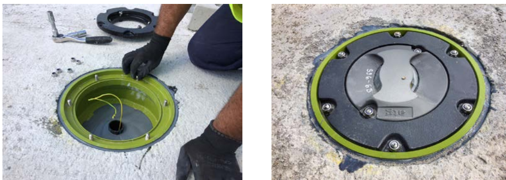
Слика 7. Уградња двосмерне светиљке осе TEL .
