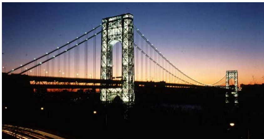
Слика 5.64 Washington Bridge Tower, САД
